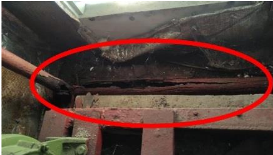
Gambar 1. Dokumentasi inspeksi visual jalur pipa 01-102-A53-2" di area ruang pompa.
